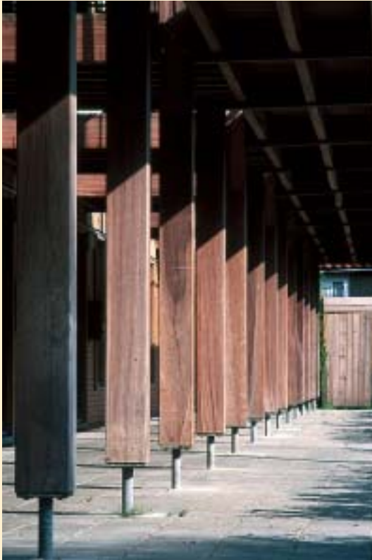
Galerijconstructie, de kolommen rusten op roestvaststalen voetplaten.
